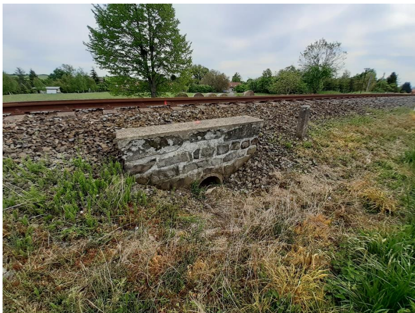
Foto č.3 - Propustek v km 7,914 - Pohled na vtok
